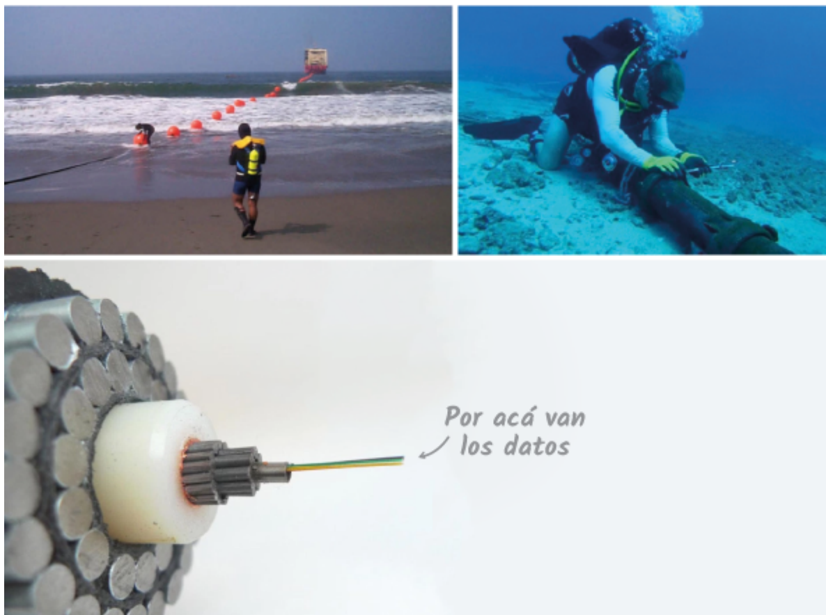
Imagen 15.1. (a) Barco partiendo de la costa para colocar el cable submarino. (b) Buzo reparando un cable submarino averiado. (c) Cable submarino de fibra óptica por dentro. 20
